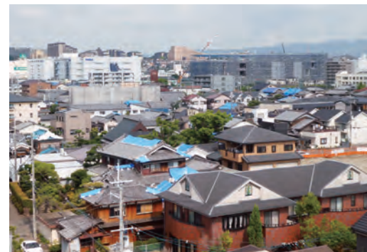
ブルーシートで覆われた屋根(大阪府)
