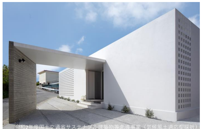
建物を白く塗装し日射反射することで建物自体の表面温度を抑えることができる。
