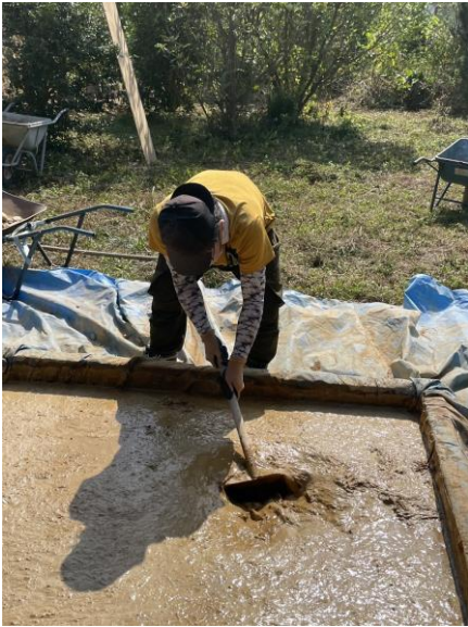
解体した土の練り直し
