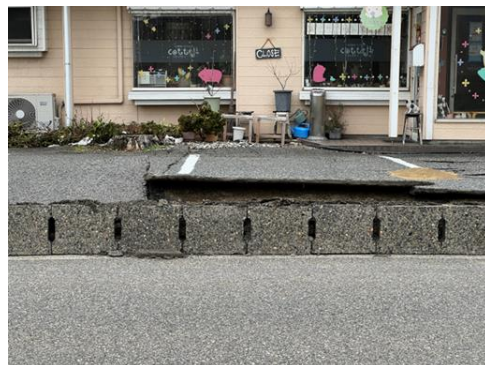
県道：新潟亀田内野線沿線
