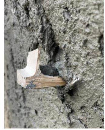
塀に打ち込んだ竹釘
