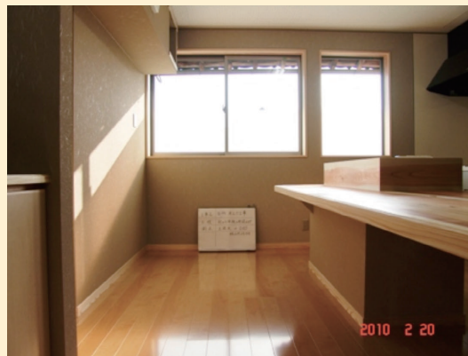
上／改修後の台所。茶の間と一体にして広くし、建具を引戸にして車椅子対応とした。また、台所の一部に洗面を設置した
