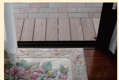
左上／中庭への出入口、右上／ベランダへの出入口。外部への出入りは居室のはき出し窓とし、ベランダ・中庭とも段差のない構造を採用した
