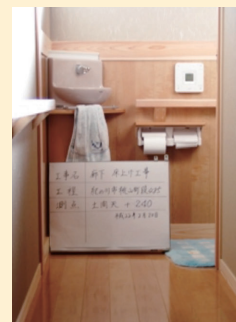
左／改修後の廊下。手摺を新たに設けた。正面は台所 右／改修後の便所。廊下との段差をなくし、建具を引き戸とした
