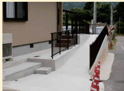
左／スロープとカーポート。車椅子マラソンの練習のための外出経路は、車両通行が少ない西側の道路であるため、そちらに向かってのスロープを設置した。右／ベランダから駐車場の移動用油圧リフト
