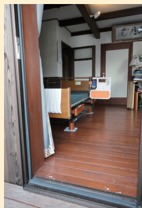
ウッドテラスから寝室を見る。玄関からの外出をあきらめ、寝室に出入口を設けた。ホームヘルパー等の介護者も、駐車場から直接この寝室へ入ることができる
