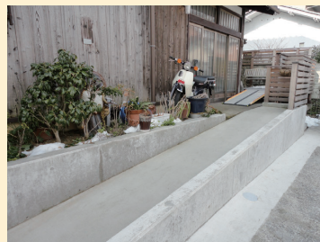
上／駐車場から玄関ポーチおよびウッドテラス方向を見る。段差を解消するスロープを設けた
