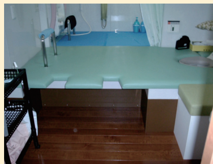
左／シャワー室・脱衣室・便所。車椅子の座面と同じような高さのマットに便器を埋め込んだ形とし、マット上を座ったまま移動して排泄・脱衣・シャワー・着衣ができるようにした
