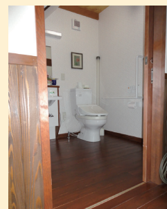
左・下／寝室から洗面化粧台・便所スペースを見る。ホームヘルパー等の介護者が利用する給湯・洗面機能を介護寝室と隣接させた。また、介護スペースを確保するため、便所と洗面所を一室とした。車椅子の移動が可能になるように、段差も解消している
