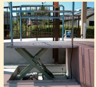
左／スロープとカーポート。車椅子マラソンの練習のための外出経路は、車両通行が少ない西側の道路であるため、そちらに向かってのスロープを設置した。右／ベランダから駐車場の移動用油圧リフト
