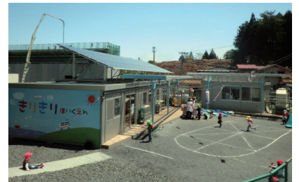
●吉里吉里保育園の仮設園舎(岩手県大槌町)。左奥：災害復興公営住宅、右奥：保育園建設予定地
