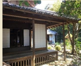
座敷廻りの土庇
