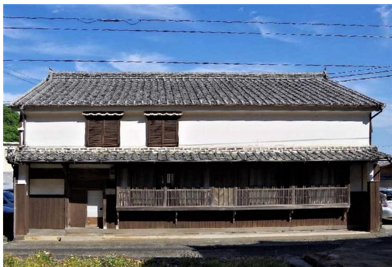
厨子二階造りの外観
