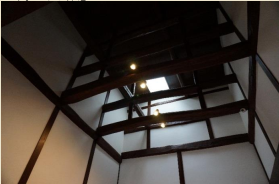
小屋組を見せた土間の吹き抜け天井
