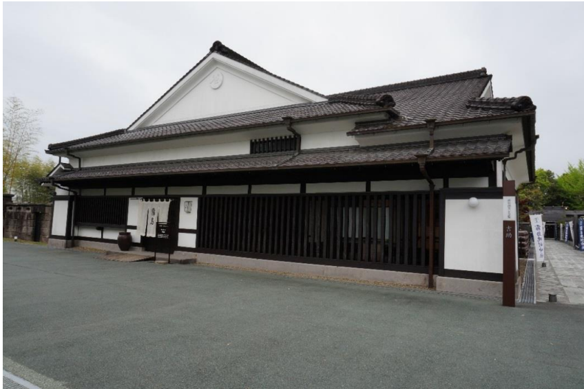
本館正面（東面）
