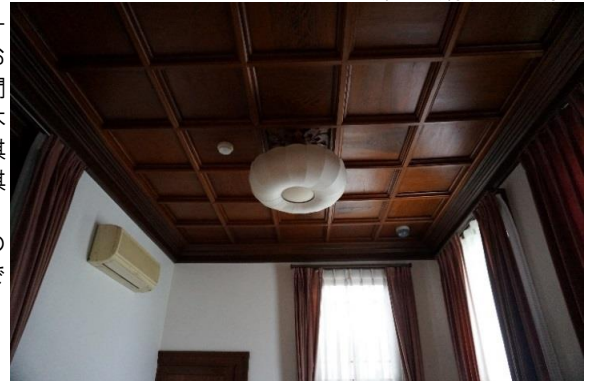
縁側奥にある洋間の基天井
