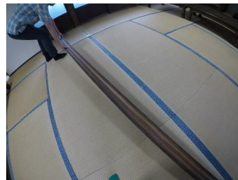
3階客室：敷居(取外し)
