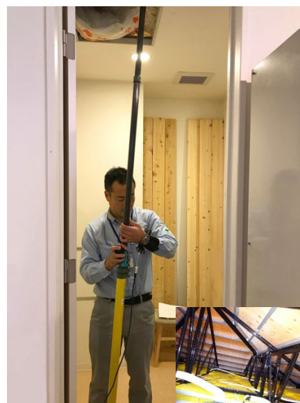
点検時の様子及び撮影された小屋裏の写真
