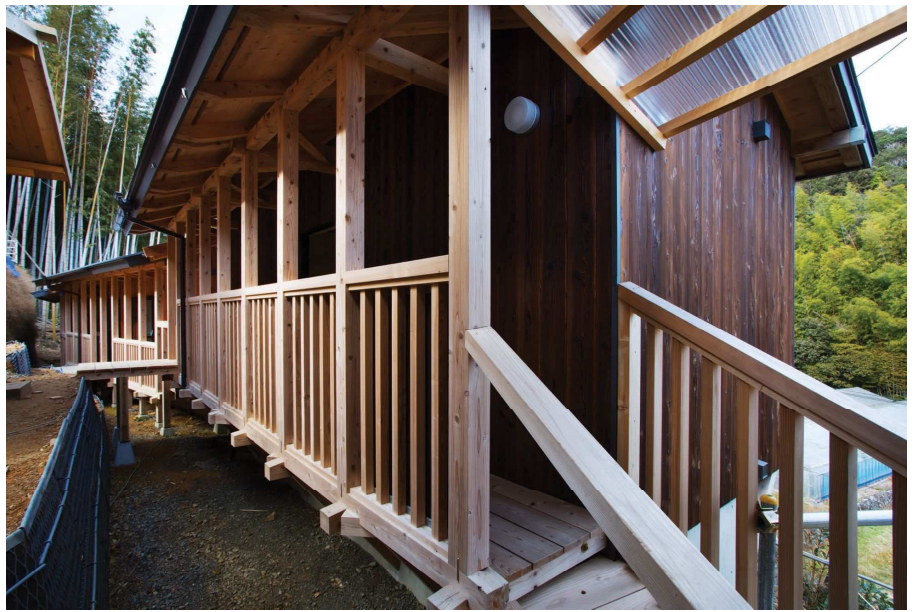
写真6 谷側の軒下空間の連なり
