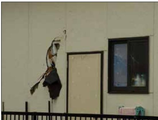
壁の一部に飛来物による突き刺さり、貫通痕がある。
