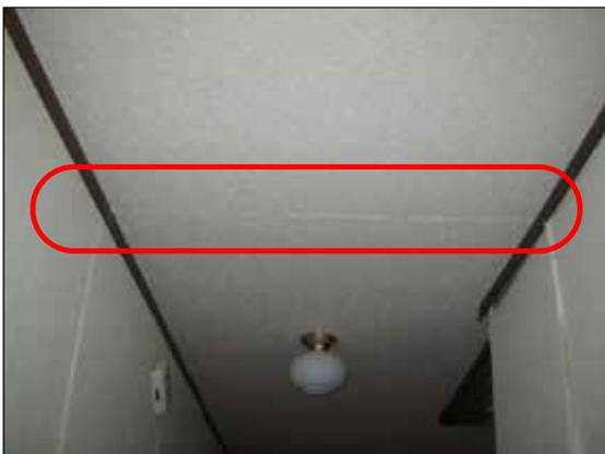
天井板に隙間が生じている。
