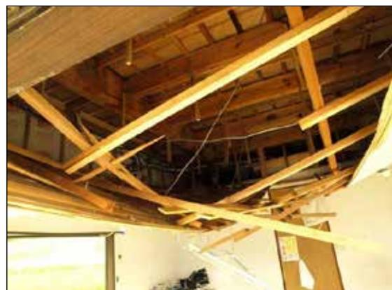
天井板が脱落している。
