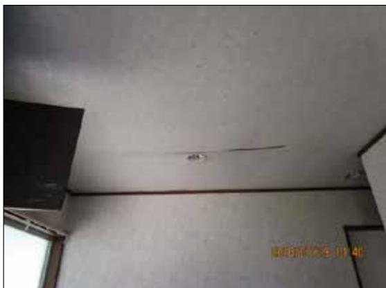
天井板に隙間が生じている。
