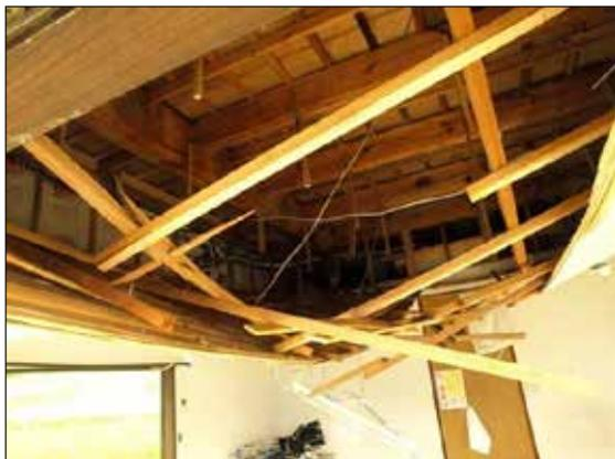
天井板が脱落している。
