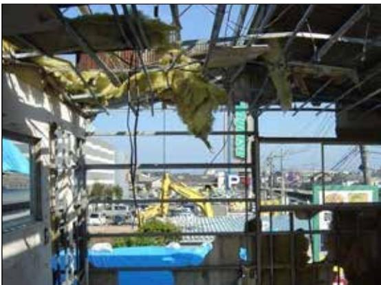
全ての仕上材が脱落している。(見切りは不要。壁1面を100%の損傷として算定する。)
