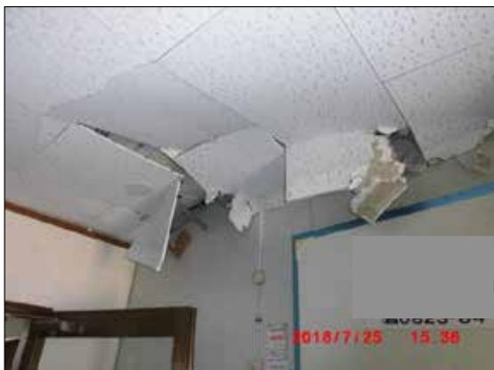
天井板が脱落している。
