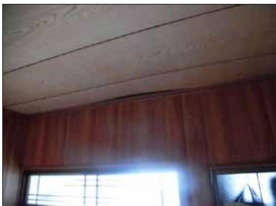
天井板の浮きが生じている。
