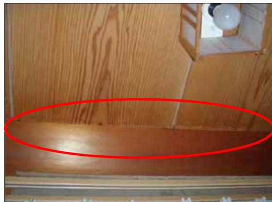
天井板に隙間が生じている。
