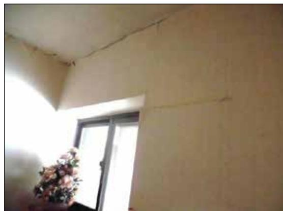
天井板に隙間が生じている。
