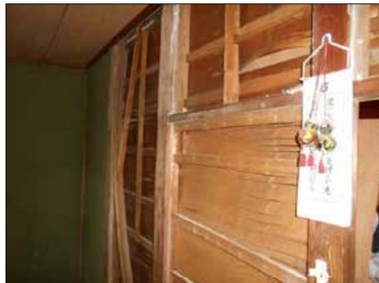
10086 仕上材が脱落しており、下地材の損傷が生じている。
