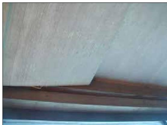
天井板の浮きが生じている。
