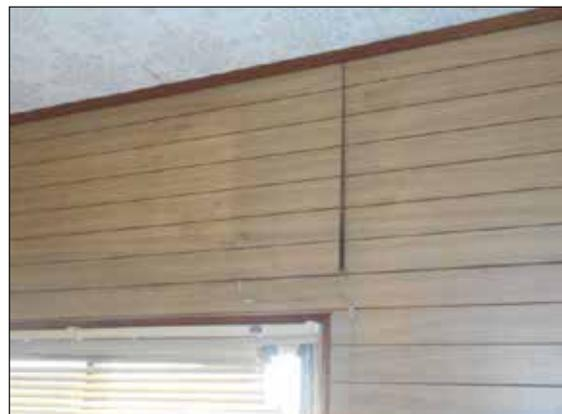
内壁合板にずれが生じている。
