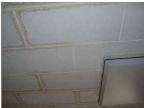
浸水による天井仕上(クロス等)の剥離・表面劣化が見られる。(下
