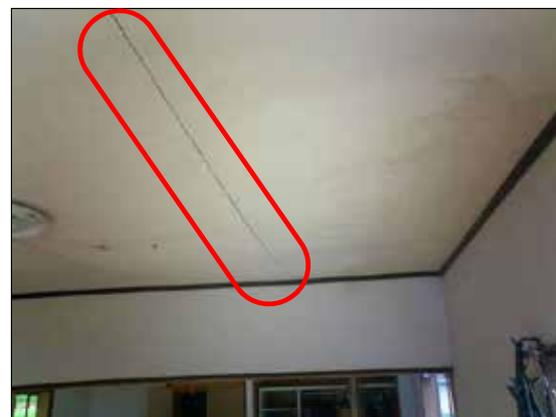
塗天井に亀裂が生じている。
