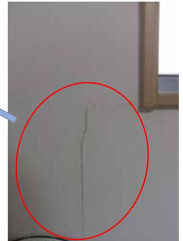
腰壁ボードの亀裂【程度Ⅰ】
