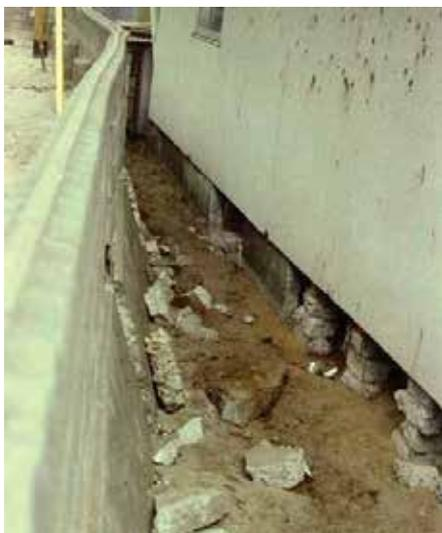
(4) 地盤面の亀裂が住家の直下を縦断・横断(対面する二辺と交差)している場合
