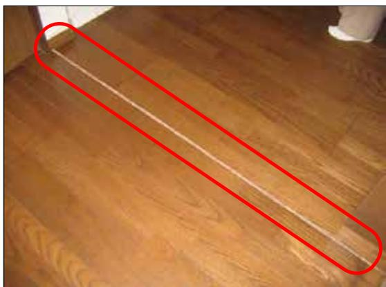
床板の継目に隙間が生じている。
