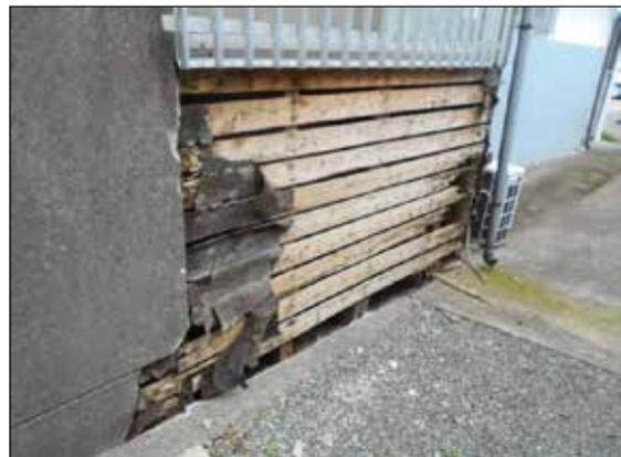
下地材に破損が生じている。
