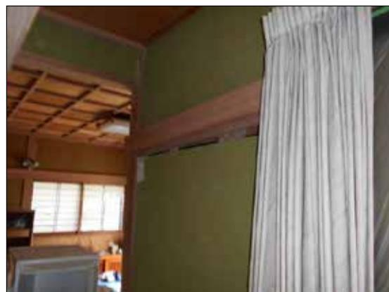
ボードの目地部に著しいずれ、釘打部の部分的な浮き上がり、隅角部の破損が生じている。
