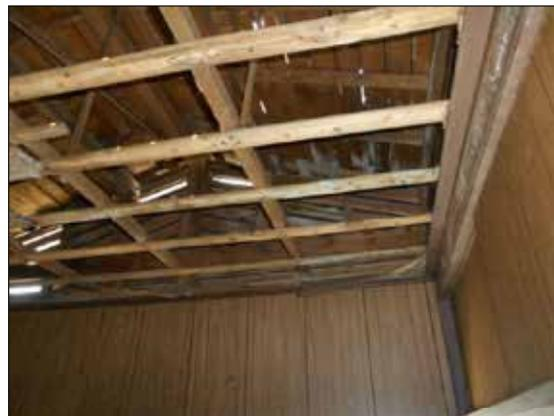
天井板が脱落している。
