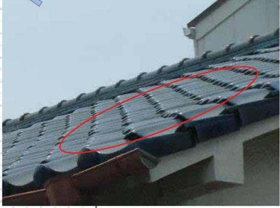
**屋根の沈下 【程度Ⅰ】**
