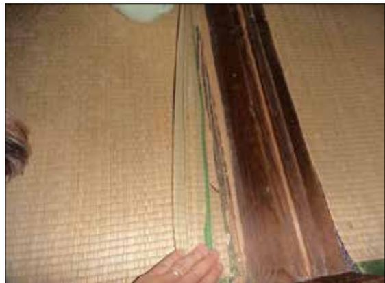
床仕上・畳に損傷が見られる。
