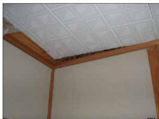
天井板の浮きが生じている。
