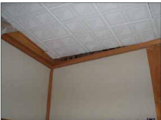
天井板の浮きが生じている。
