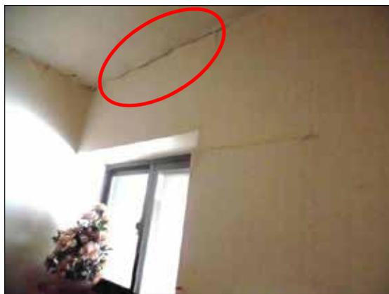
天井板に隙間が生じている。
