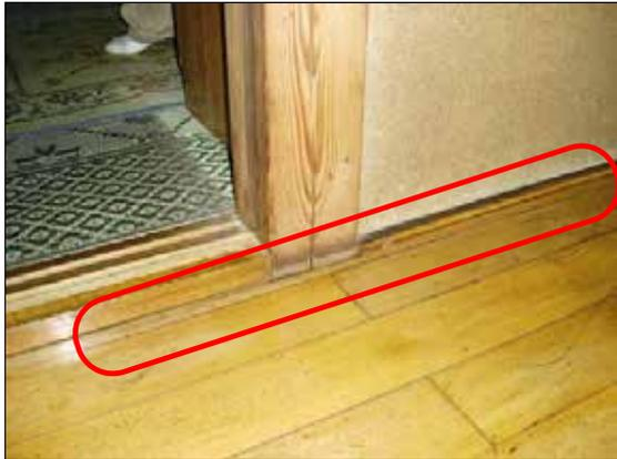
床と壁との間にわずかなずれが生じている。
