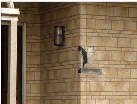
壁に飛来物の軽微な衝突痕がある。
