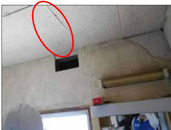
天井板に隙間が生じている。
