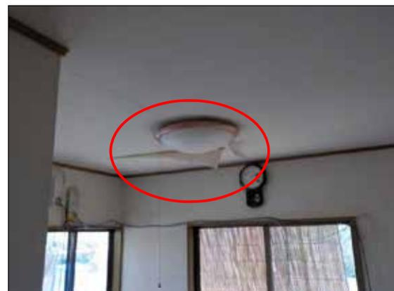
浸水による天井仕上(クロス等)の剥離・表面劣化が見られる。
