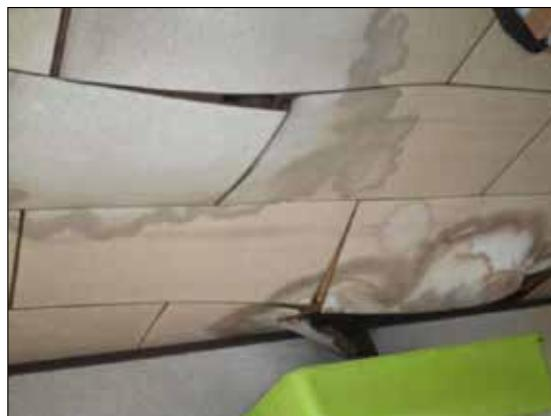
浸水による下地材・化粧せつこうボード・その他天井材の吸水・膨張・不陸等の機能損失が見られる。(下地材・天井板の交換を要する程度)
