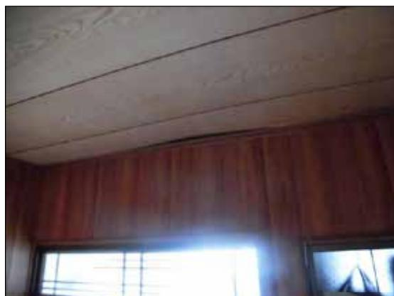
天井板の浮きが生じている。
