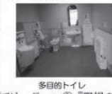
多目的トイレ
