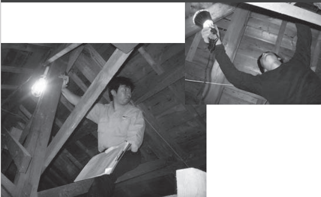
建築士会による調査及び図面化作業
