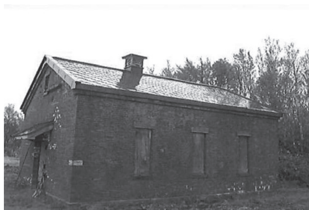
C棟 屋根部分修復完了 平成19年
