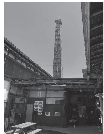
敷地内から煙突を見る
