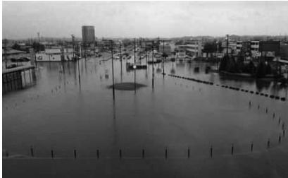
秋田駅東ロータリ冠水
