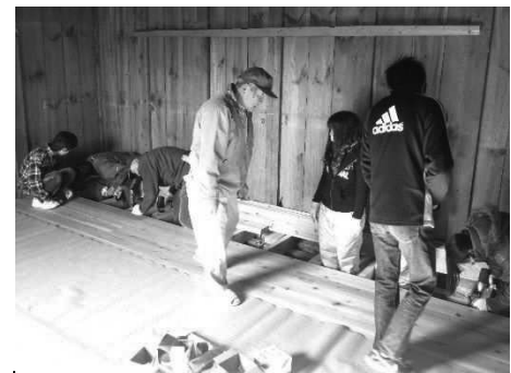
ボランティアによる石蔵改修工事
