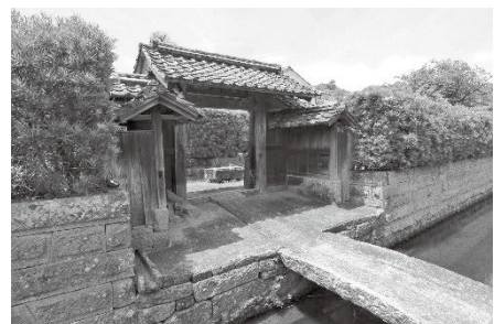
▲用水路に架かる石橋と武家門
