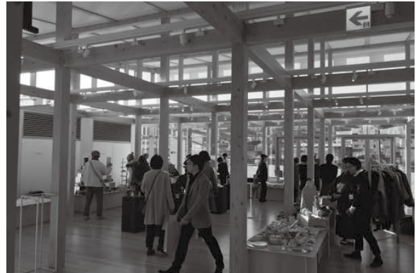
グールド・イン・ロッド工法の2.7mスパン柱梁による市民ラウンジ
