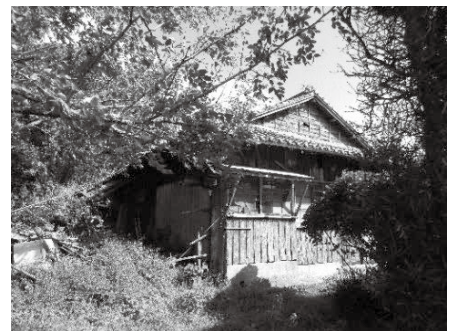
▲解体されようとしていた旧山之内邸
