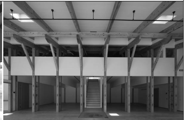
【完成写真】一階アトリエ・事務室から階段室を見る
