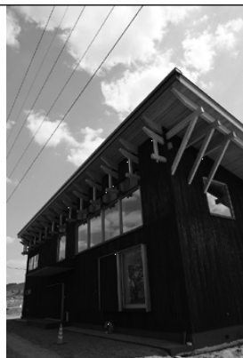
【完成写真】北側軒の出
