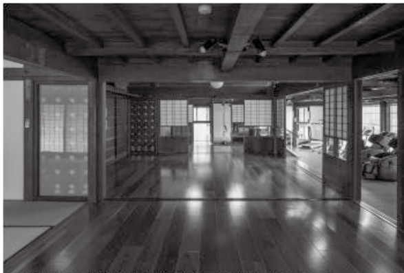
伝統的木造住宅をラチス状耐力壁で耐震補強し、改修した多世代交流スペース
