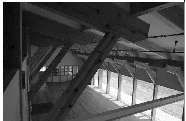
【完成写真】二階より一階吹抜け部を見る
