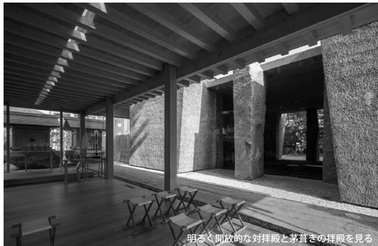
ガラスで囲われた対拝殿，構造材は福岡県産のヒノキ，賽銭箱は2017年の九州北部豪雨で被災した受難木のヒノキ
