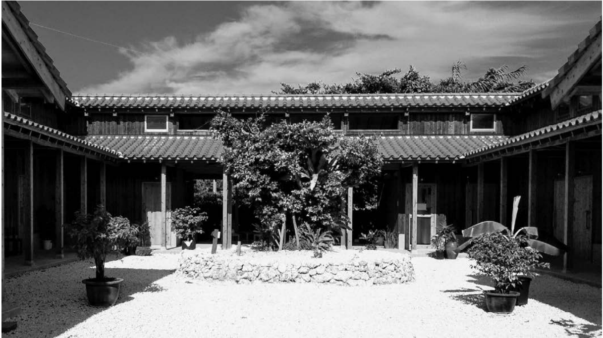
屋根は塩害と台風強い沖縄産の赤瓦屋根とし、維持管理を考慮して棟漆喰ではなく棟瓦で押えました。外壁は島の民家で見られる杉板相じゃくり貼りとし、中庭は島の石と砂利と植物で作りました。
