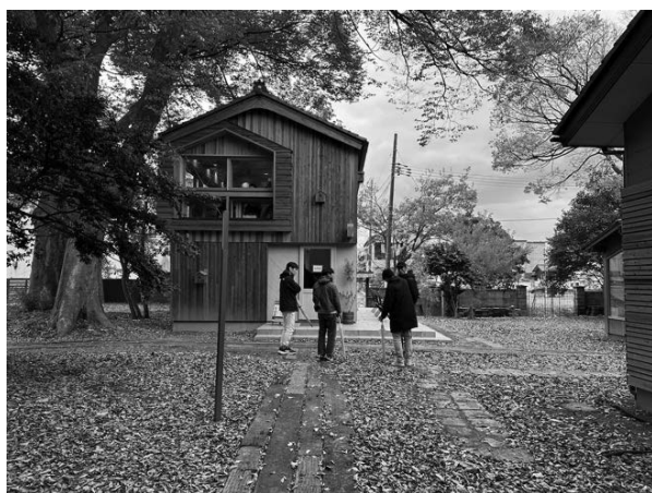
事例1：新潟市秋葉区「マチーシャの杜」 企画：にいつ研究所 設計：神田陸建築設計事務所 施工：馬場工務所
