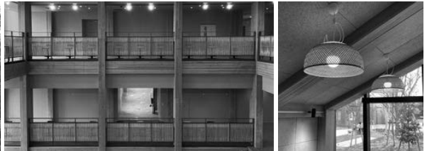
別府竹細工による吹抜手摺り・照明シェード 大分発祥の接合金物（ホームコネクター工法）
