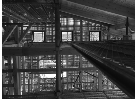
【工事中】土壁下地のえつり
