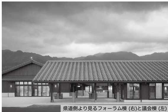
県道側より見るフォーラム棟(右)と議会棟(左)
