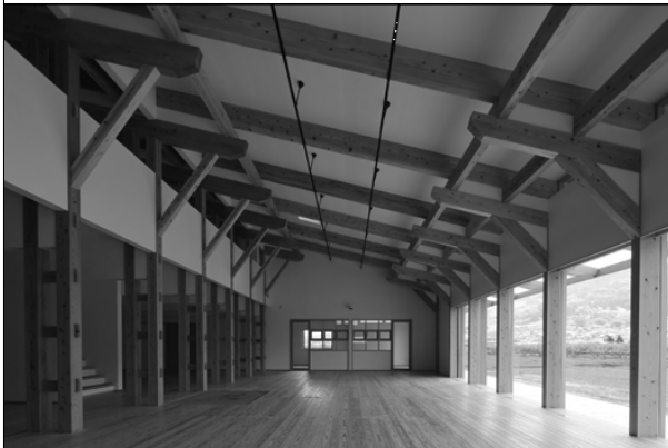
【完成写真】一階アトリエ・事務室からキッチン側を見る
