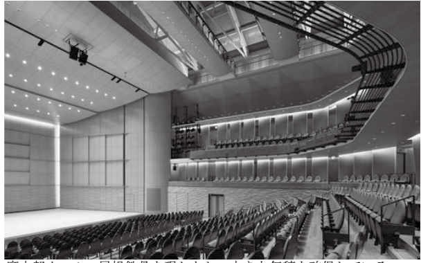
廉太郎ホール：屋根鉄骨を現しとし、大きな気積を確保している
