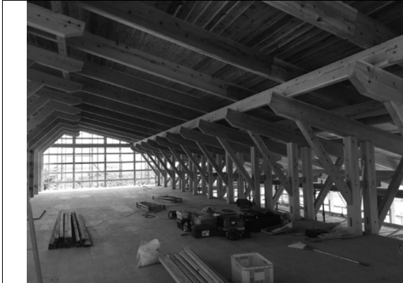
【工事中】二階東面を見る
